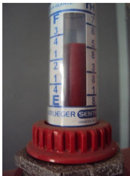
Figura 26 - Indicador de nível
