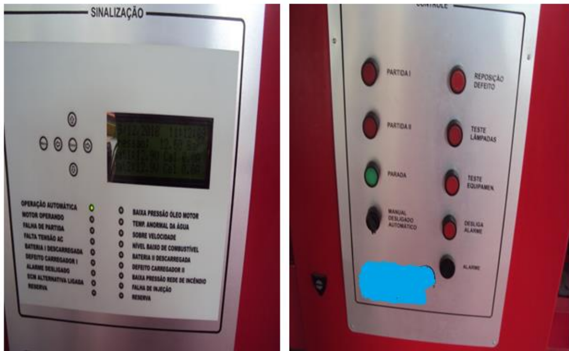
Figura 23 - Painel elétrico da bomba
