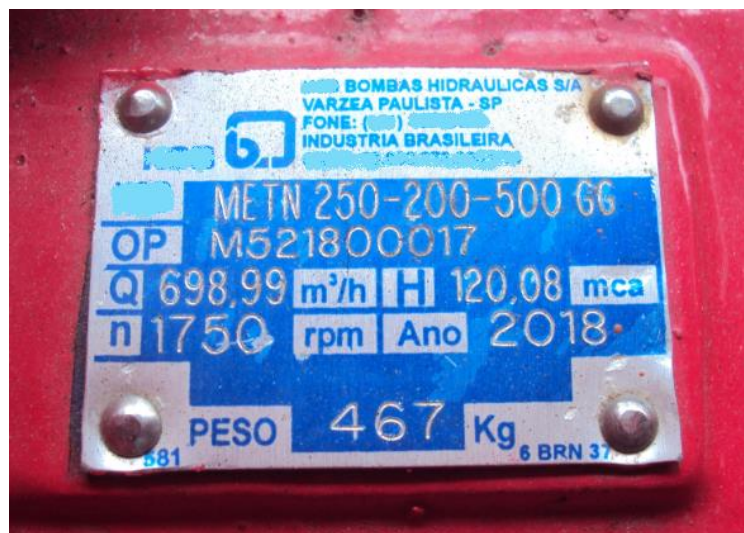
Figura 14 - Placa de identificação da bomba
