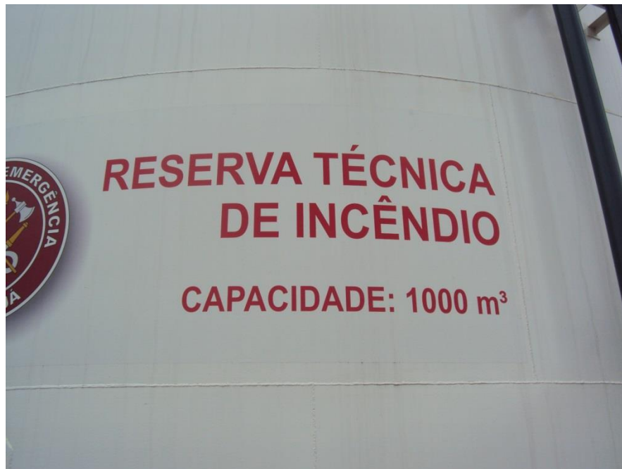
Figura 29 - Reserva técnica de incêndio
