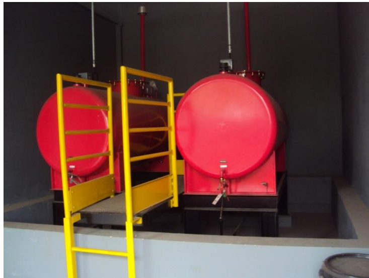
Figura 25 - Tanques de diesel
