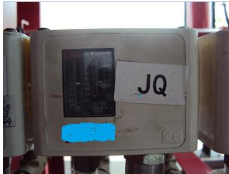
Figura 31 - Pressostato da bomba Jockey
