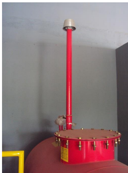
Figura 27 - Respiro do tanque
