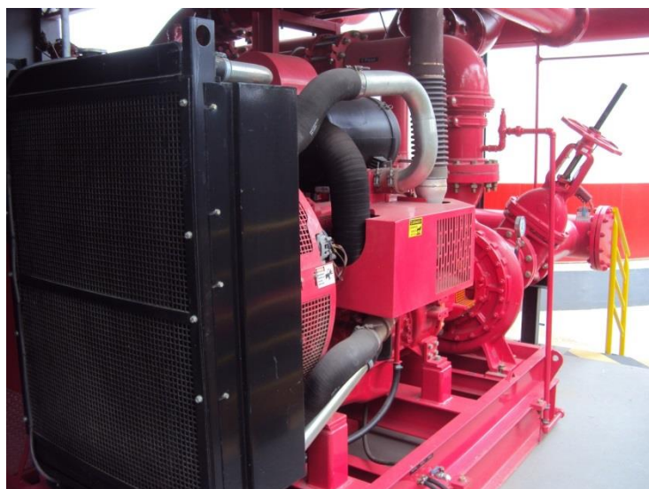
Figura 33 - Motor a diesel refrigerado por radiador
