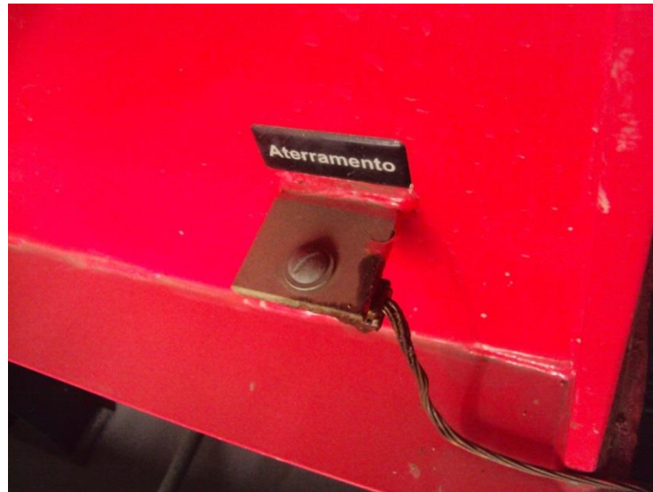
Figura 28 - Ponto de aterramento
