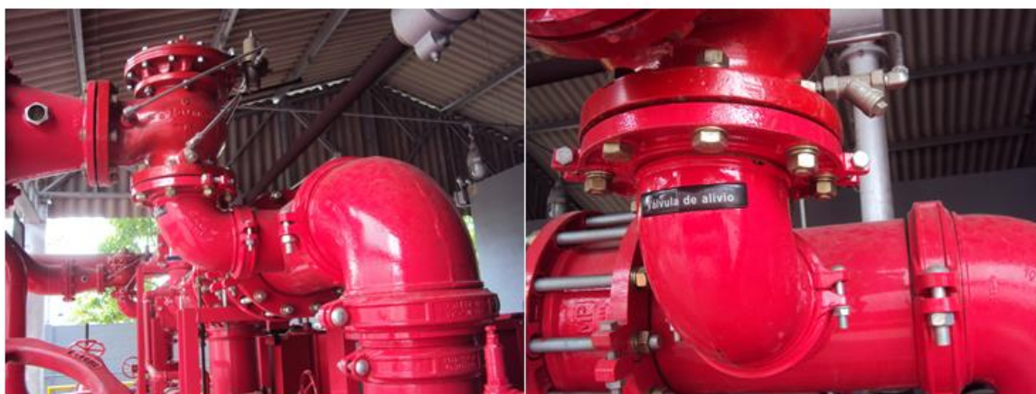
Figura 16 - Válvula de alívio e válvula de retenção
