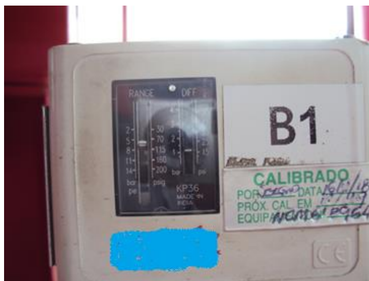
Figura 34 - Pressostato da bomba diesel
