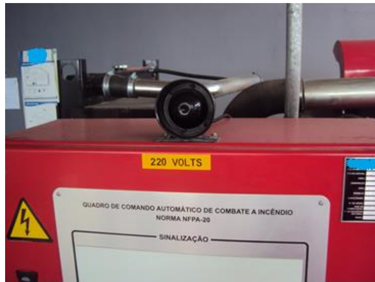
Figura 36 - Sirene de emergência
