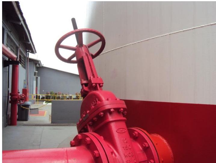
Figura 17 - Válvula gaveta com haste ascendente
